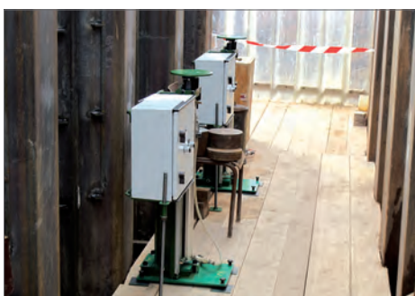
strumentazione durante le prove in situ
